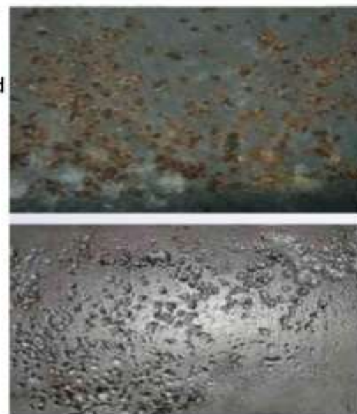
Imagen 3. Placas metálicas afectadas por corrosión por picadura.
